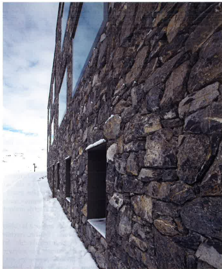
L'ouverture de l'ancienne gare a été fermée avec du vitrage offrant une vue vertigineuse sur les sommets.
